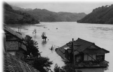
S28 山麓間見渡す限り浸水
